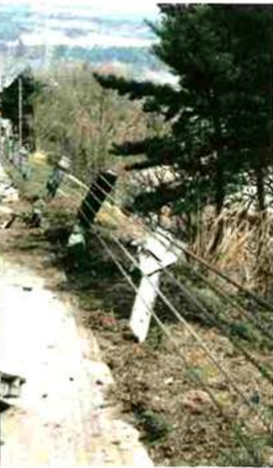
中央自動車道での多重事故(須玉町地内)
