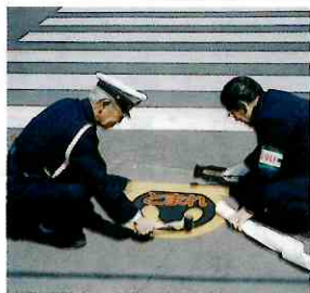
線が開通したので、このほど同道路での歩行者の安全を守るため、横断歩道や交差点等の手前の路面に「ストップマーク」を十六箇所設置しました。この道路は、敷島南小学校の通学道路でもあるところから、安協支部役員や町交対協職員等が図柄や設置場所等を検討して、新型のストップマークを路面に表示したもので、歩行者の安全が保てると町民から喜ばれています。
