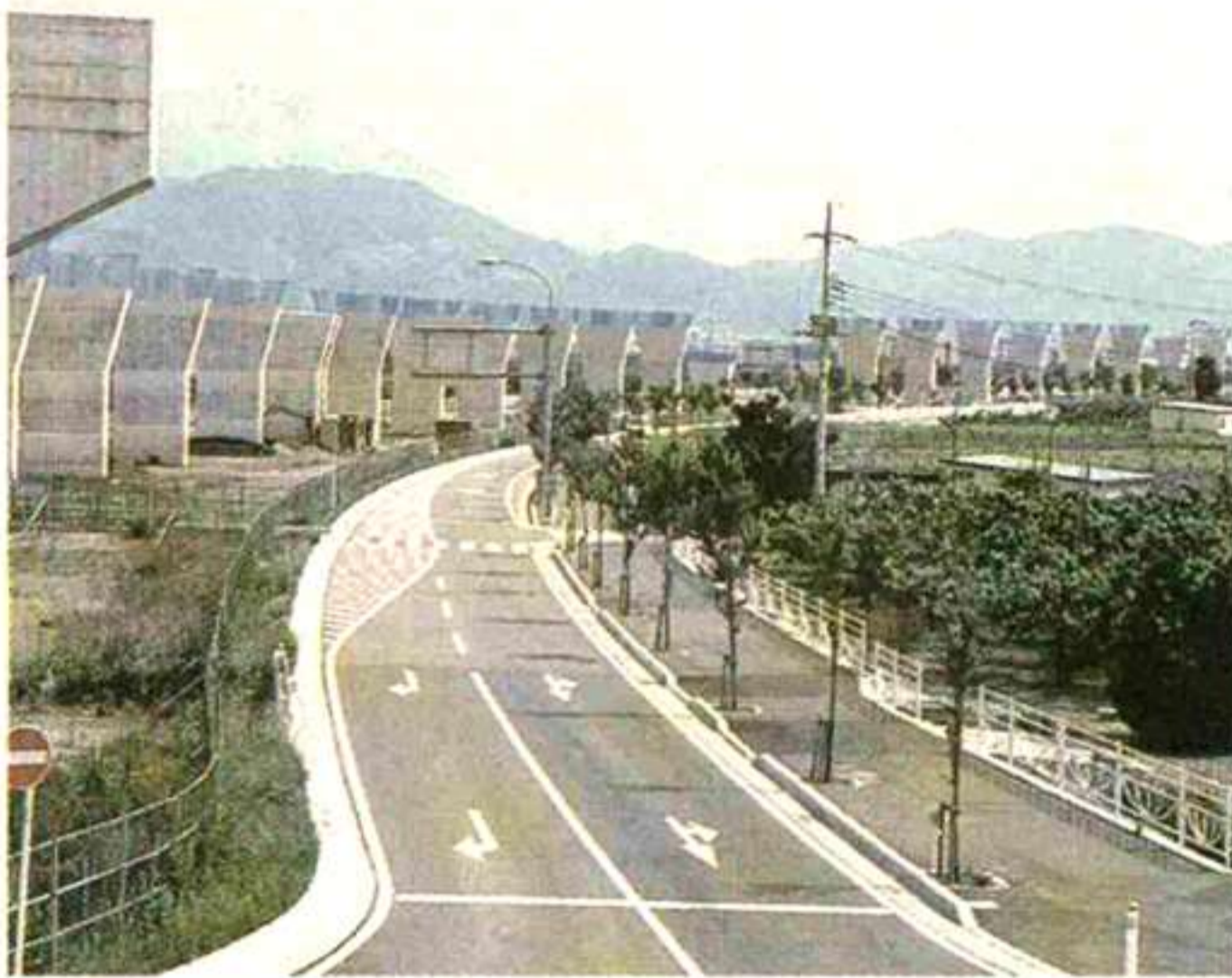
建設中の中部横断自動車道。高規格道路によって県民の生活は利便性が図られる
