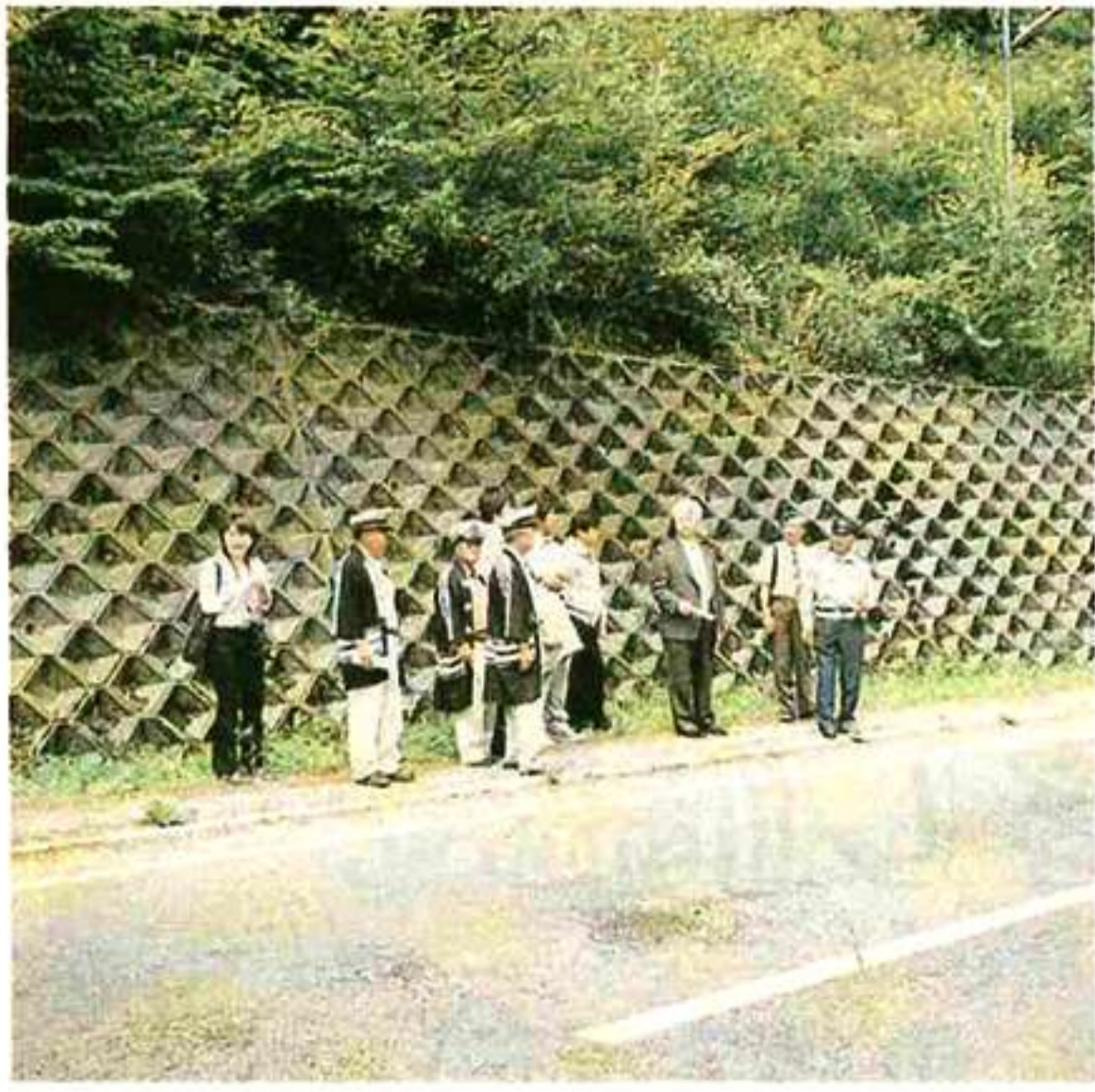
弁論大会での指摘を受けて交通事故が発生した県道カーブ現場で今後の対策を協議する道路関係者
