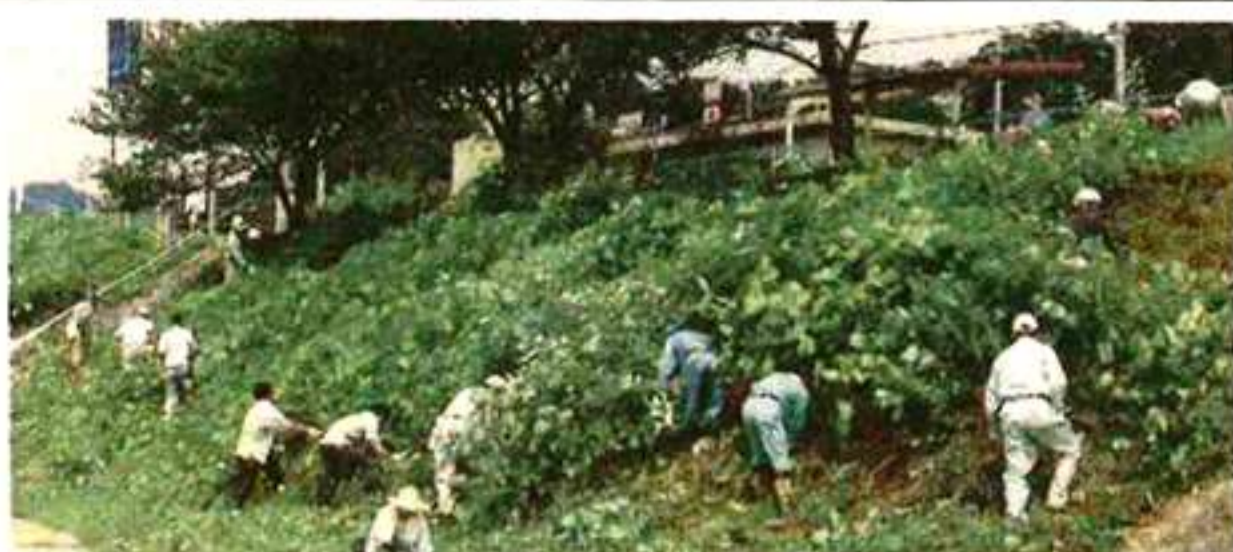
草刈り作業をする山梨県建設業協会の会員
